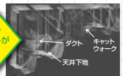
大ホール天井内部の3次元点群データ
